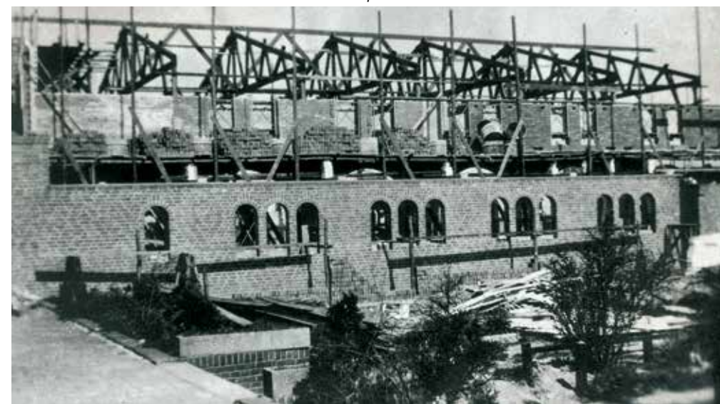
Het oude dak op nieuwe muren
